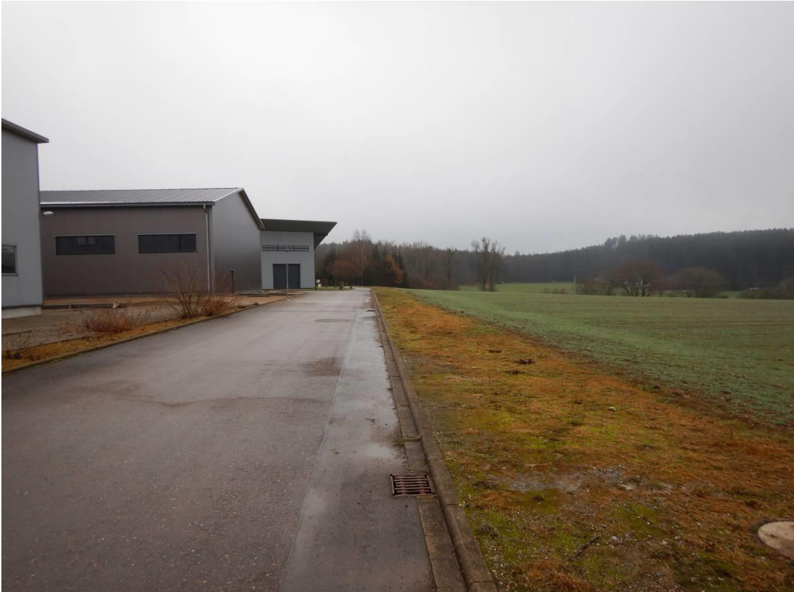
Blick entlang des Asphaltweges am südlichen Firmengelände, Blickrichtung Süden.
